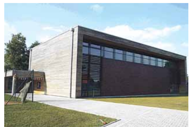
Turnhalle in der Samtgemeinde im Passivhaus-Standard
